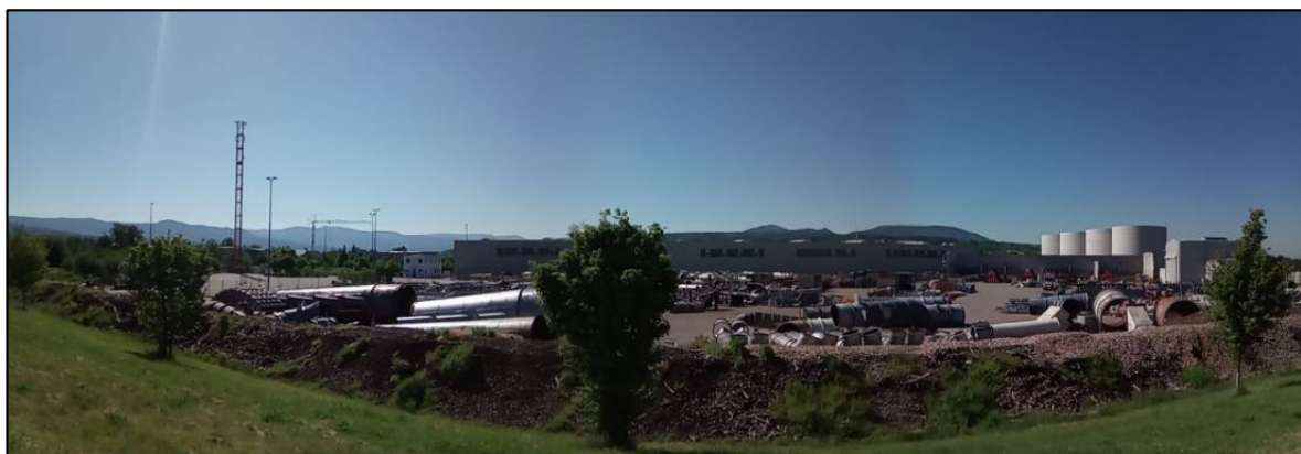
Abbildung 2: Blick von Norden auf das Kronospan-Areal mit den Produktionshallen und –anlagen (Aufnahme vom 07.05.2020)
